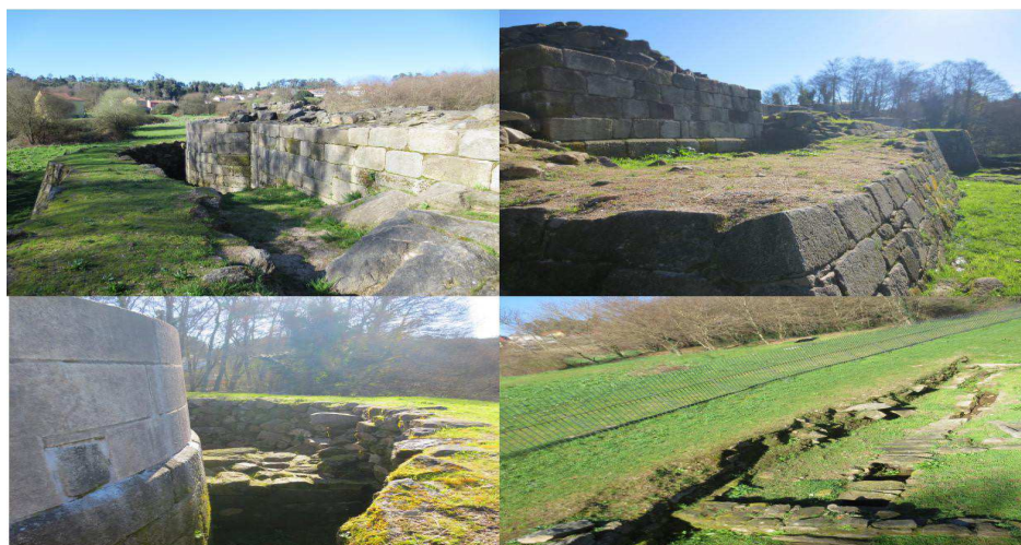
Fig. 4: De arriba izquierda a abajo derecha: liza y torreón SO. Identificación de elementos de la muralla donde se puede observar: torre de la primera cerca (elevada sobre la muralla), primera cerca, segunda cerca y canalizaciones. Muro transversal intermuros en una de las torres esquineras que delimita y acota el espacio, reduciendo la movilidad del atacante, se observa también la segunda muralla exterior. Sistema de canalizaciones en la zona Sur
